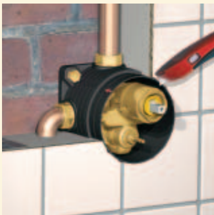
4. Отрезать излишки кожура из эластомера с помощью ножниц или ножа.
