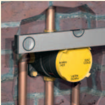
1. "Примерить", выровнять, привинтить и соединить с трубами. Оптимальная глубина встройки 80-110 мм.
