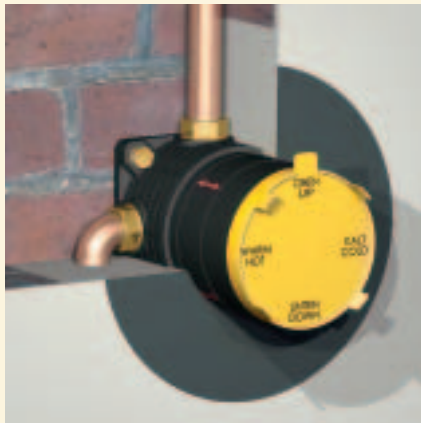
2. Наложить штукатурку и наклеить манжеты-уплотнители.
