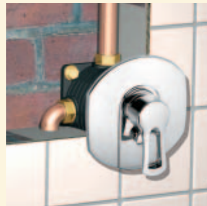
6. Монтаж внешней части смесителя.
